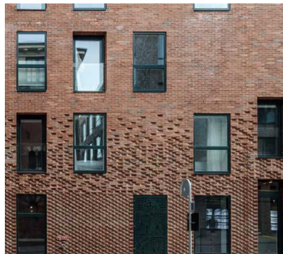
Abb. 58 // Versetzte Fenster innerhalb eines Rasters
