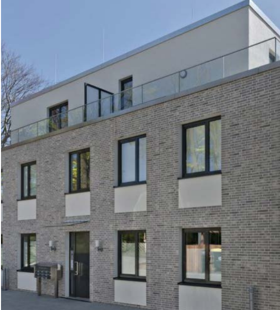
Abb. 31 // Putzfassade zurückgesetztes oberstes Geschoss
