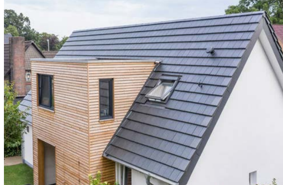
Abb. 67 // Flache Dacheindeckung in grau
