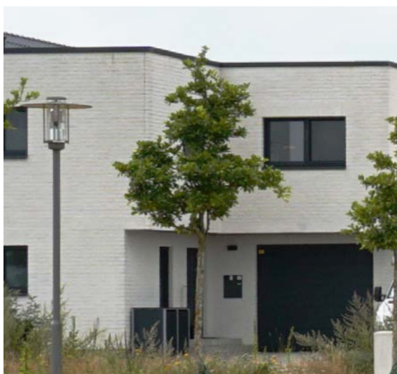
Abb. 75 // Garage im EG mit Eingangsbereich kombiniert
