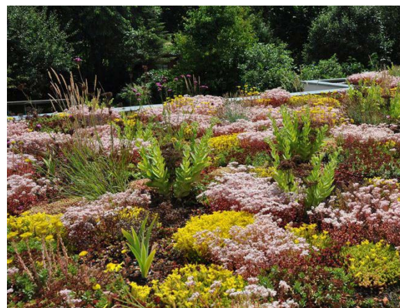
Abb. 71 // Beispiel extensive Dachbegrünung
