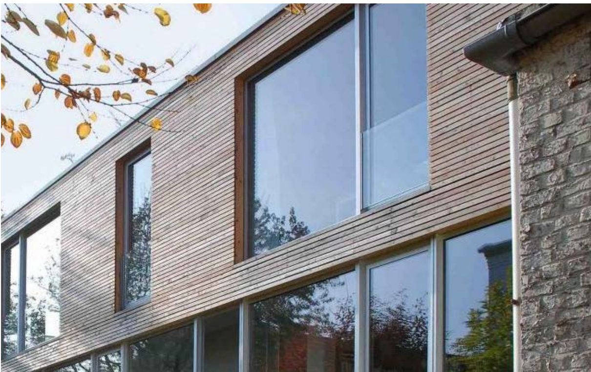
Abb. 40 // Holzverkleidung oberes Geschoss
