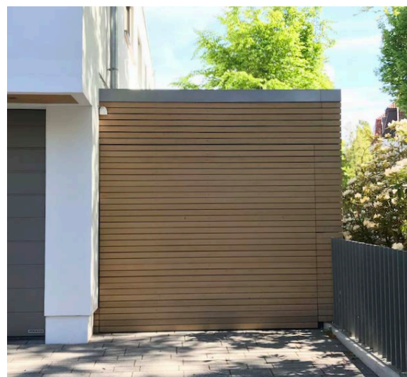
Abb. 76 // Garage als seitlicher Anbau
