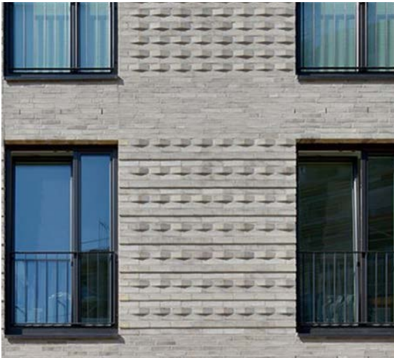
Abb. 55 // Bodentiefe Fenster mit Brüstung
