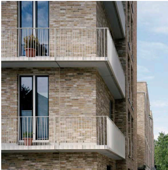
Abb. 51 // Balkone mit hellen Metallbrüstungen
