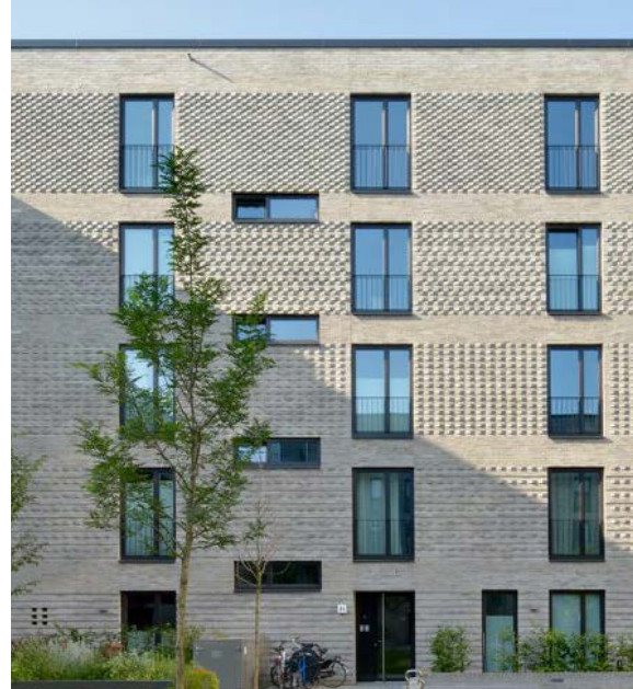
Abb. 28 // Beispiel Backsteinfassade, Pergolenviertel
