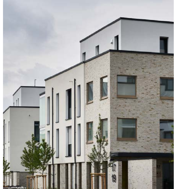
Abb. 32 // Putzfassade zurückgesetztes oberstes Geschoss
