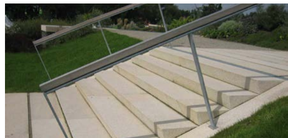
Abb. 128 // Treppe mit Handlauf
