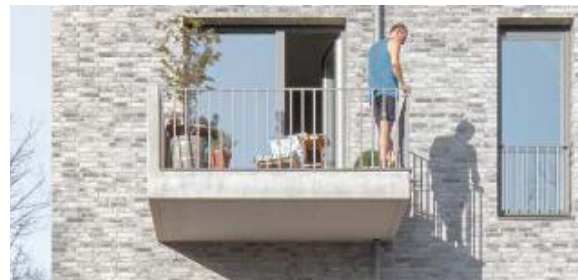
Abb. 48 // Beispiel auskragender Balkon
