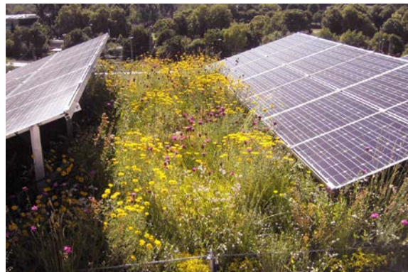
Abb. 72 // Photovoltaikanlage und Dachbegrünung
