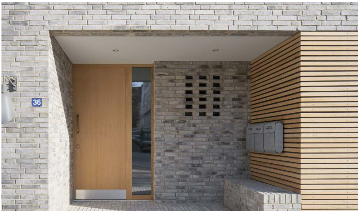
Abb. 60 // Hauseingang mit Materialwechsel Klinker und Holz
