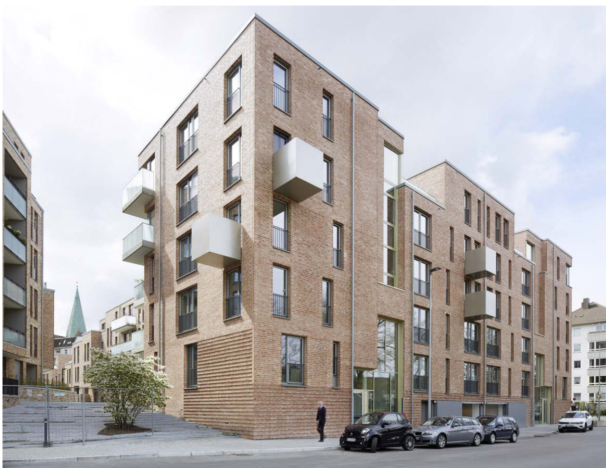
Abb. 187 // Beispiel Sockelgeschoss mit einladender Treppenanlage vom Straßenraum
