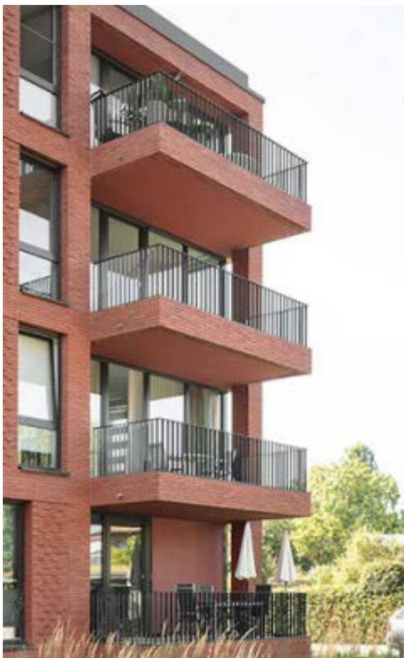
Abb. 53 // Balkone mit auskragenden Balkon-Platten in der Materialität der Hauptfassade
