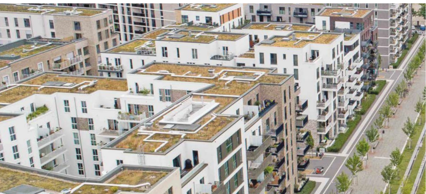
Abb. 61 // Dachlandschaft mit Flachdächern und Dachbegrünung
